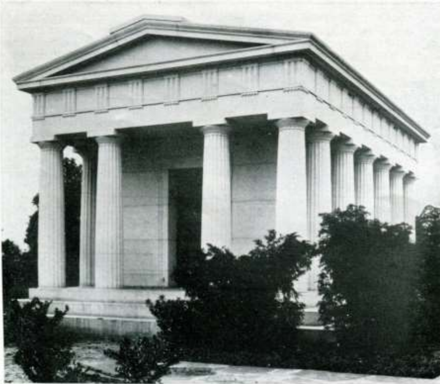
CONE MAUSOLEUM, GREENSBORO, N. C. McDonnell & Sons, Buffalo, N. Y., Contrs.
